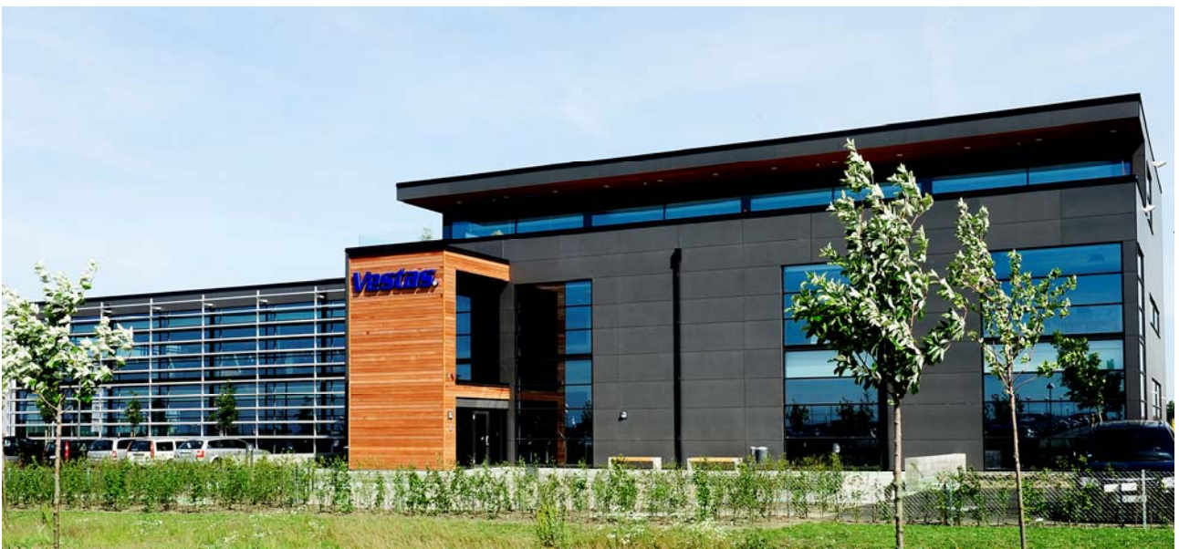
I mars 2009 färdigställdes Vestas nya huvudkontor i Svågertorp, Malmö
