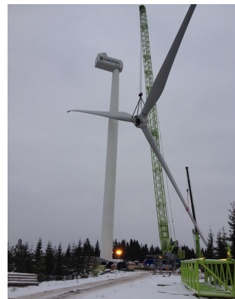
Idag lyftes rotorn på plats på det första kinesiska vindkraftverket i Europa. Plats: Molkom i Värmland.
