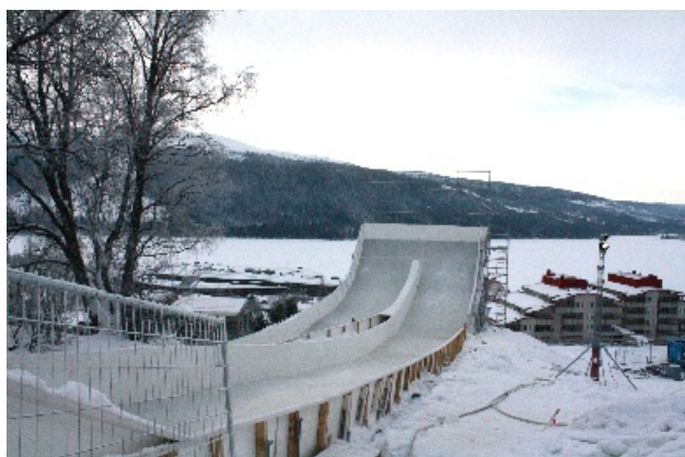
Den mäktiga "wallriden" ovanför Åre by under konstruktion. Foto: Fieldwork
